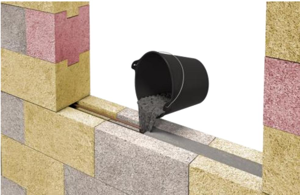
Figure 43 : coulage du béton dans l'appui de fenêtre
